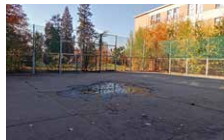
Oprava povrchu víceúčelového hřiště č. 304, ul. Nad Ovčírnou – před realizací
