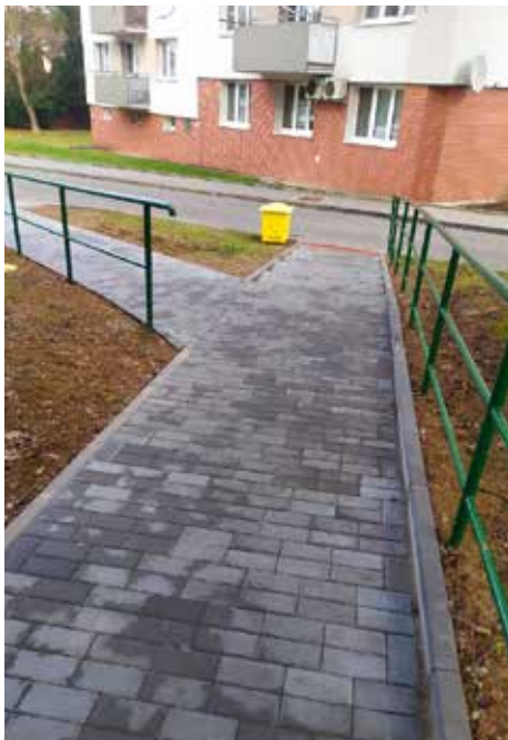
Bezbariérové úpravy chodníku – Mokrá – zrealizováno
