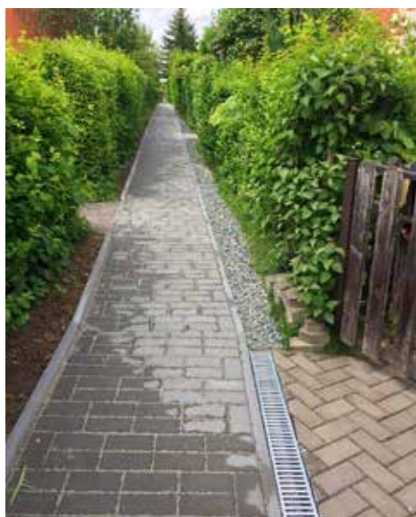
Oprava průchozího chodníku mezi ul. Pod Vrškem a ul. Pod Školou – zrealizováno
