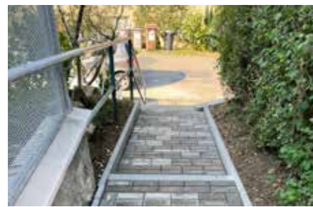
Oprava chodníku, který vede z ulice Příkrá mezi domy č. p. 6912 a 3524 a směřuje k domu č. p. 3525 – realizace bude hotova v září 2022
