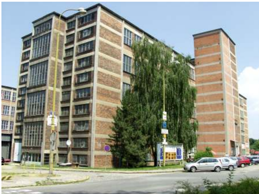
14. budova zlínského továrního areálu
