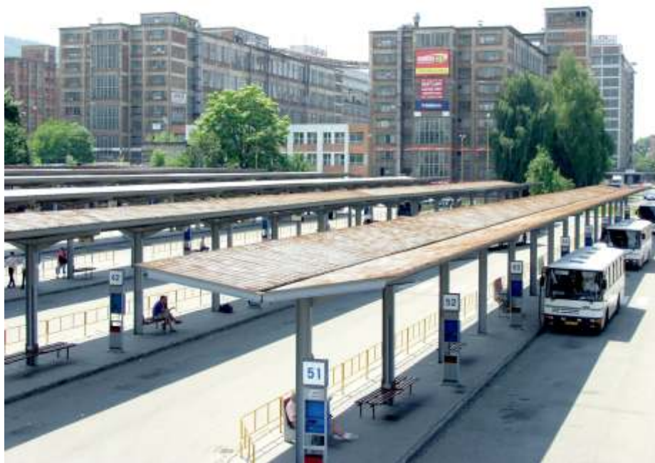
14. a 15. budova zlínského továrního areálu – budoucí sídlo Krajského kulturního a vzdělávacího centra
