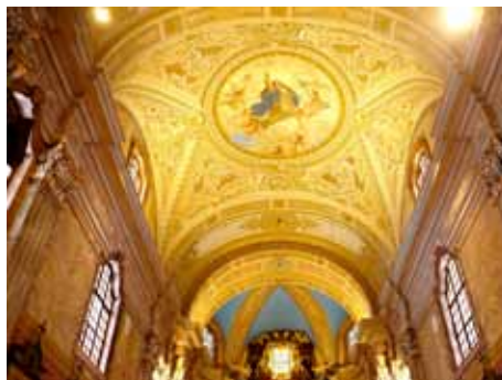
Opravený strop kostela. / foto: Ivo Hercík
