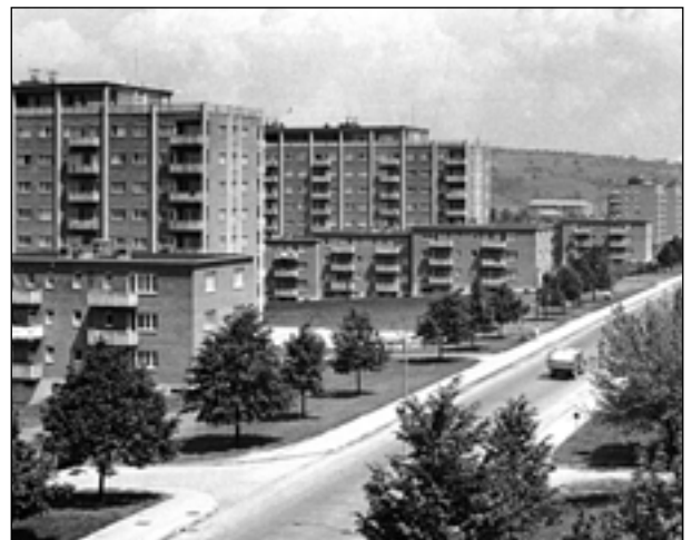
Východní část Zlína, urbanistické řešení Vladimíra Kubečka, věžové a Morýsovy domy Miroslav Drofa, třípodlažní bytové domy Vladimír Karfík, vedoucí skupiny Jiří Voženilek, 50. léta, KGVUZ
