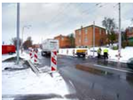
Rekonstrukce přechodu / foto: Ivo Hercík
