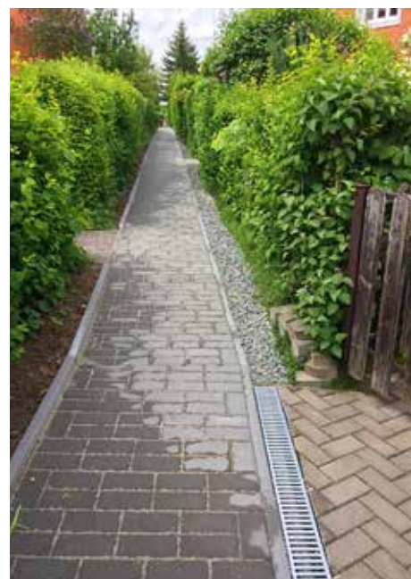
Oprava průchozího chodníku Pod Vrškem
